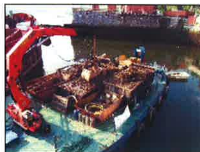
Pontona con grúa
