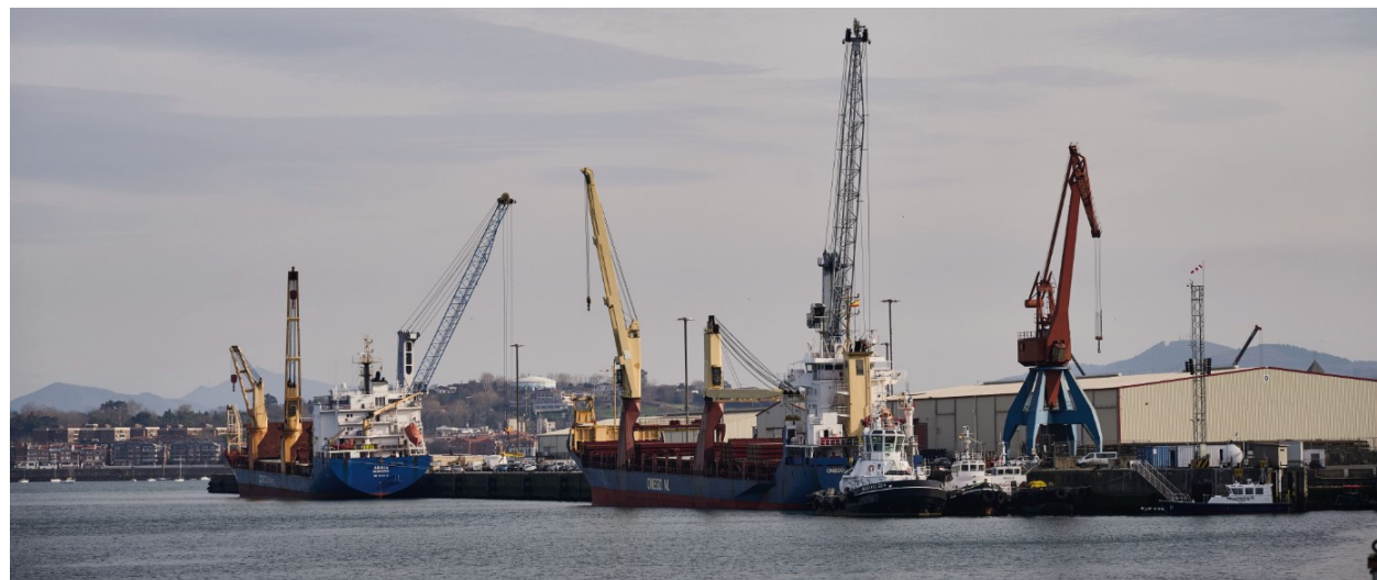
A_18 Descripción sintética de los principales focos de emisión (puntuales y difusos) del puerto, que suponen emisiones acústicas significativas.
