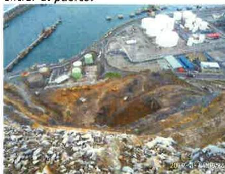
*Esta primera fase incluirá, además, la estabilización de la antigua cantera de Punta Lucero para, acompañando su ejecución a la del Espigón Central, utilizar el material sobrante de la cantera como relleno del muelle.*
