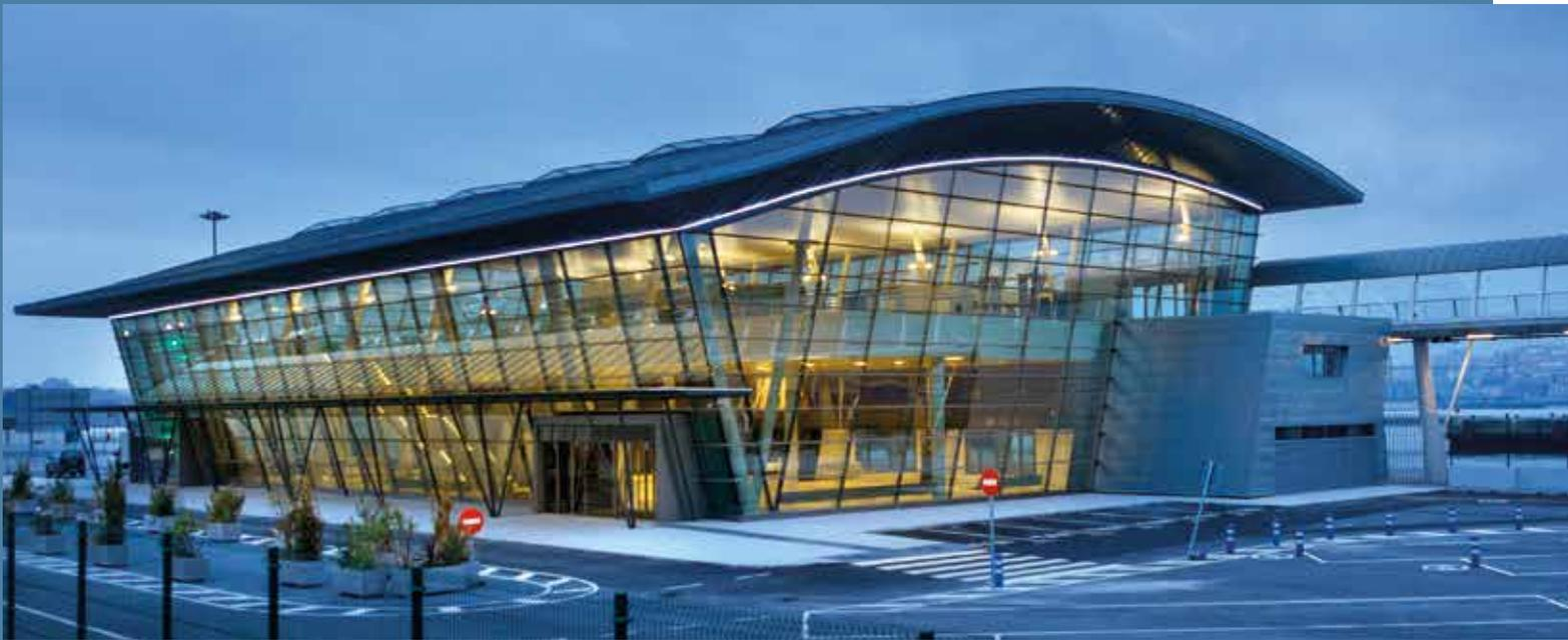
Con **15 metros de altura y 3.200 m<sup>2</sup> útiles**, está concebida como un gran contenedor acristalado de planta rectangular y con una cubierta inclinada de zinc, aportando ligereza, dinamismo y luminosidad al edificio.
